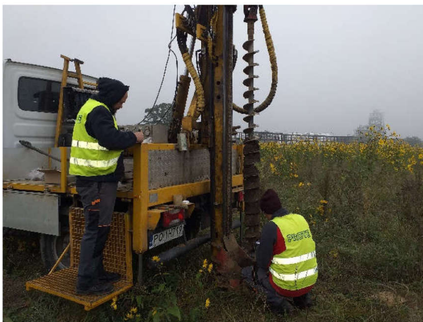
Fotografia nr 2. Wiercenie otworu badawczego (13.10.2020 r.).
